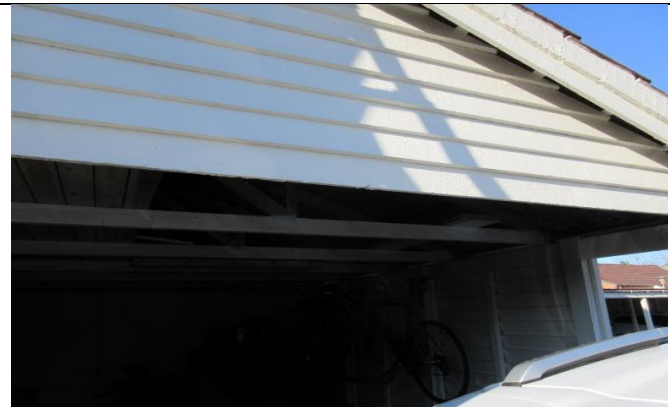
10A Beklædning ved carporte og udhus, generelt uden større nedslidning.
