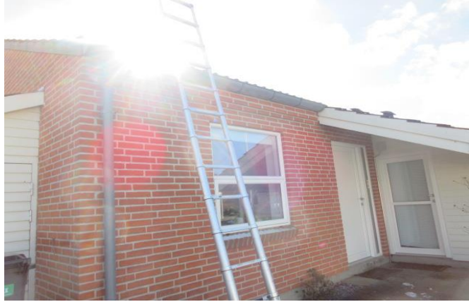
8B Sokkel generelt pæn uden større skader
